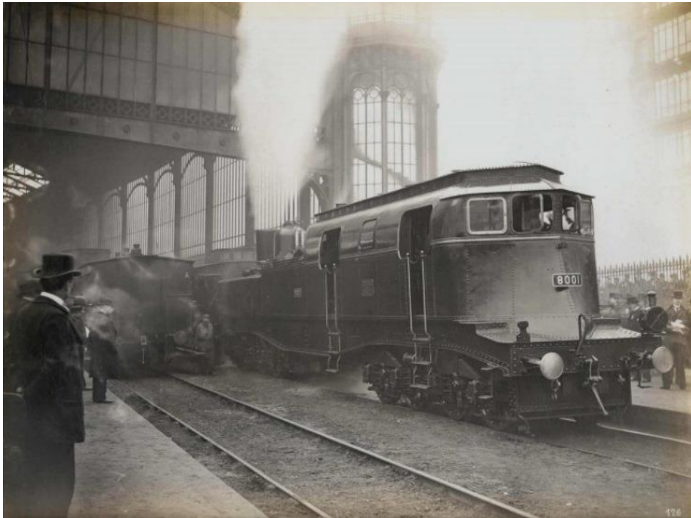
Essai de la locomotive électrique Heilmann N° 2 à la gare Saint-Lazare en 1897
