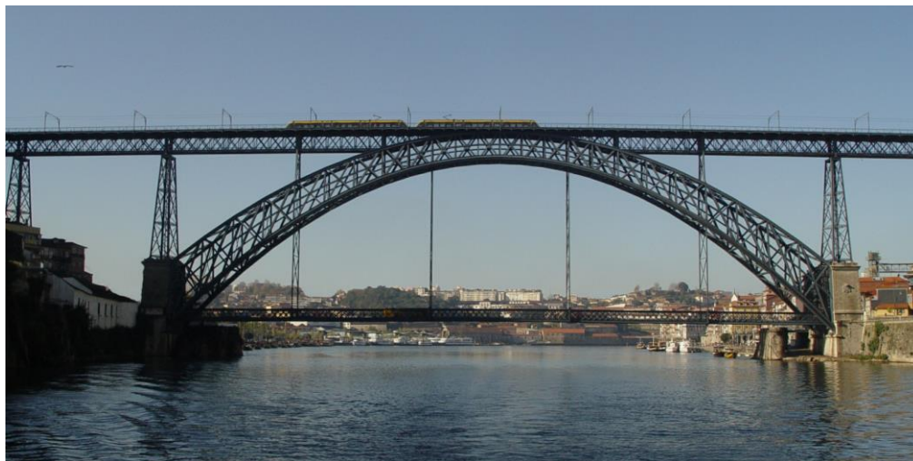
Pont de Porto
