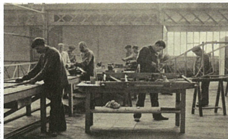
Assemblage de la poutre et du châssis, Levallois, 1911. Assembly of the fuselage girder and its chassis, Levallois, 1911.
