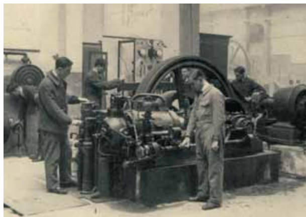
Moteur à gaz de 25 CV Atelier des machines thermiques
