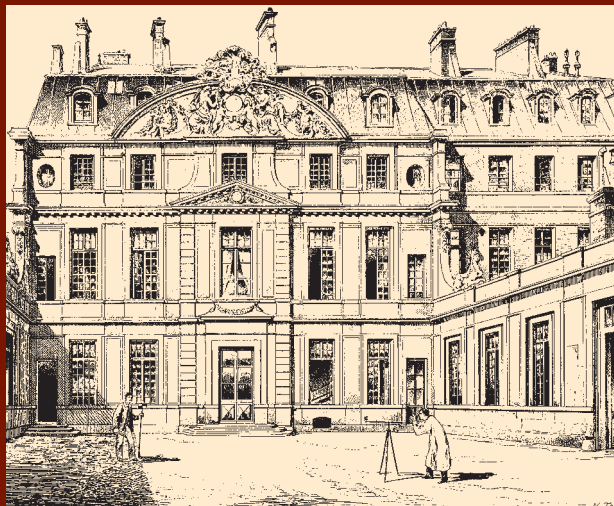
Façade rue Thorigny
