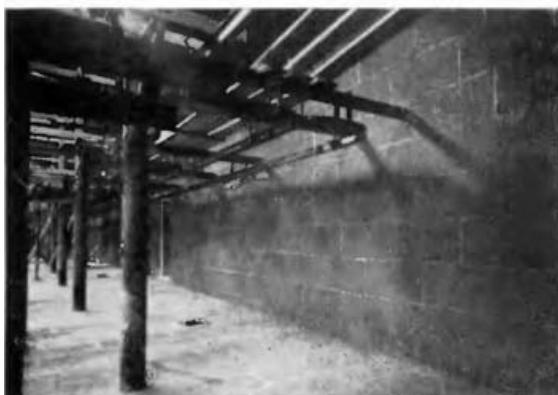
Enduits en liège sur plaques de liège. Frigorifiques des ABATTOIRS DE LA MOUCHE, à Lyon.
