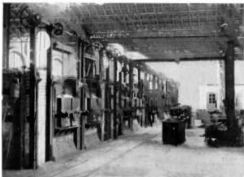
*Batterie de Fours de traitement thermique.*
