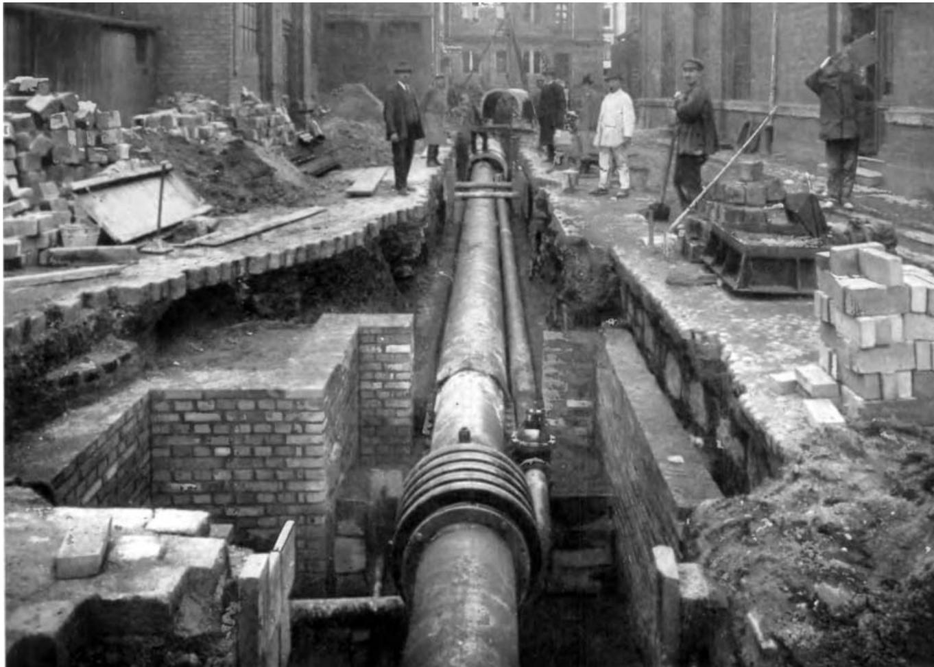
*Installation en cours d'exécution. En avant, l'organe de compensation des dilatations; derrière cet organe, une petite partie de la grosse conduite apparaît sans calorifuge; à côté de cette conduite, la petite conduite ramenant l'eau de condensation à l'usine centrale; l'ensemble des deux conduites sera renfermé dans une canalisation en béton armé constitué par des arceaux dont l'un va être mis en place.*
