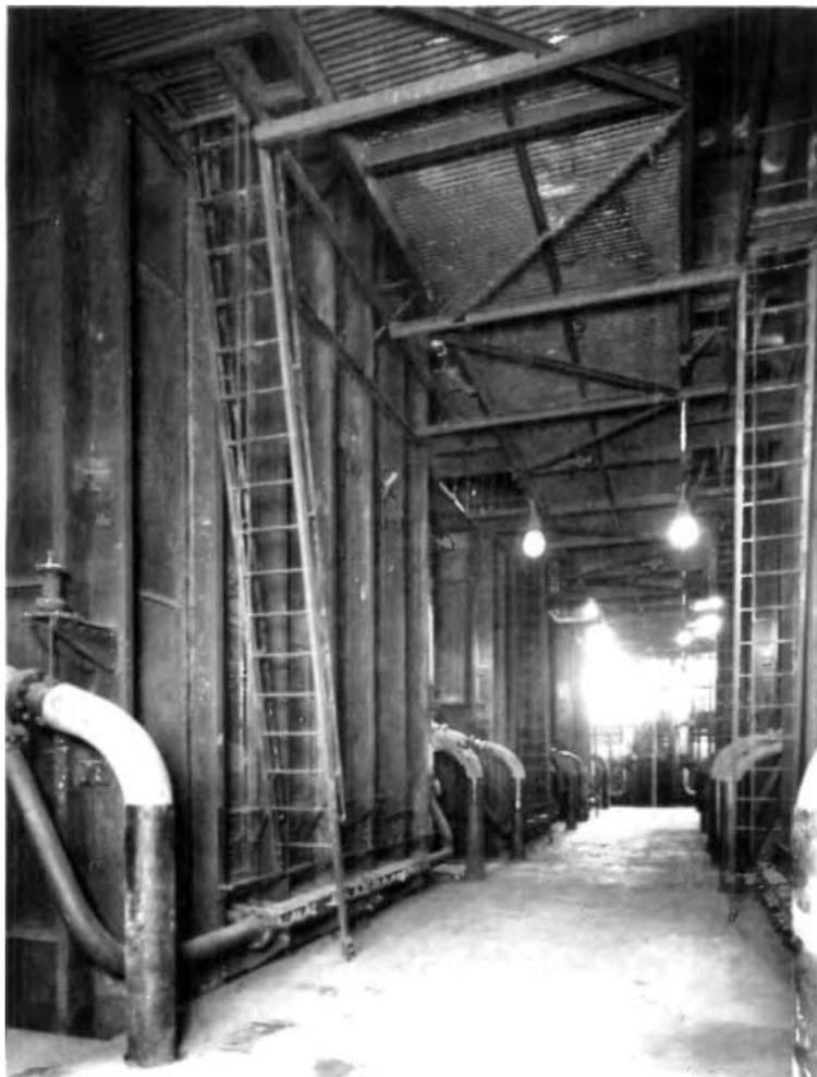
*Chaudière au charbon pulvérisé, chambres de combustion.*
