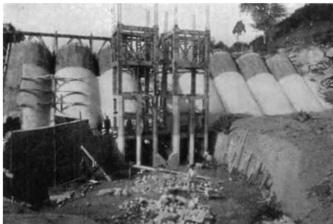
BARRAGE DE LA ROCHE QUI BOIT. — *Vue des voûtes du barrage et des ouvrages de vidange en construction.*
