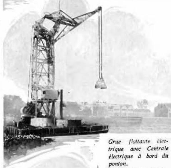
*Grue flottante électrique avec Centrale électrique à bord du ponton.
