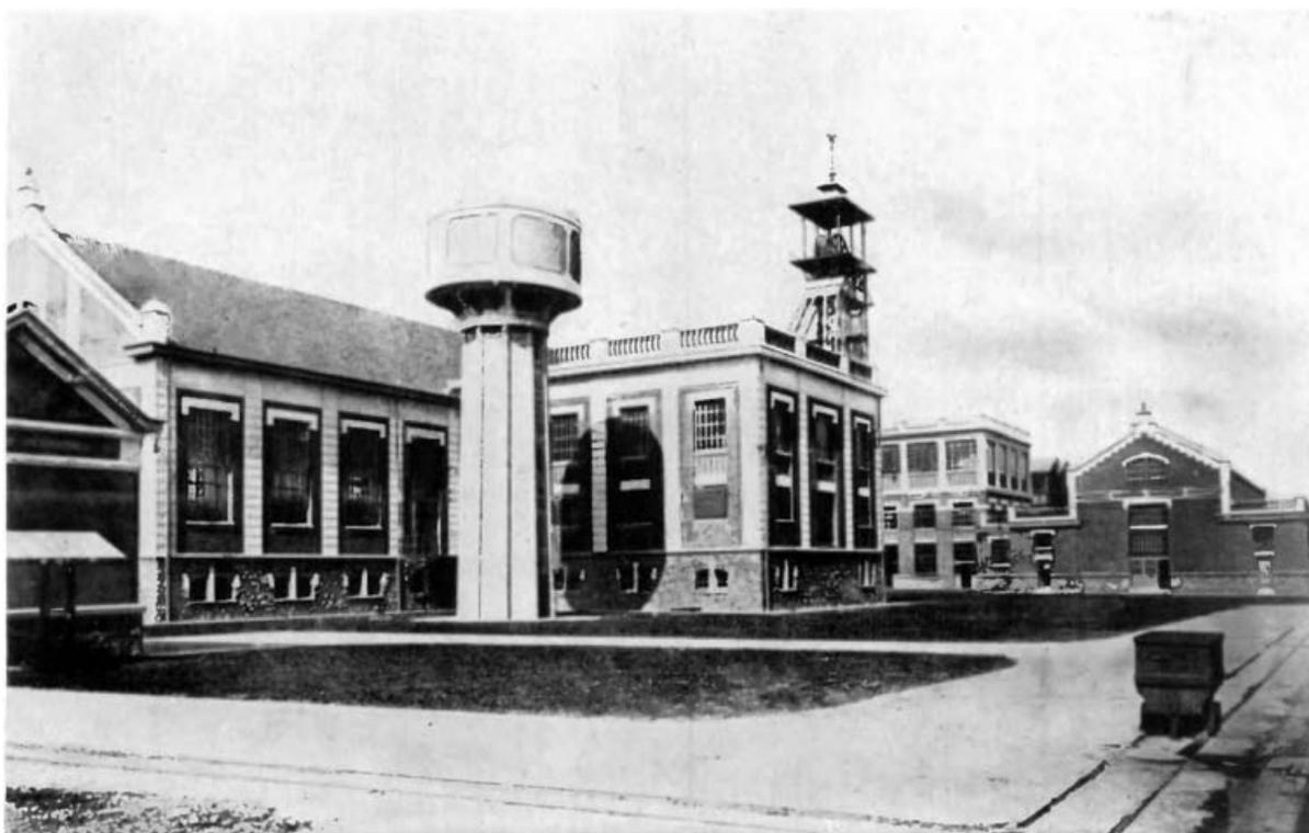
MINES DE LENS. — Vue générale d'une fosse d'extraction ; au premier plan, la Salle des machines et le Poste de transformation.
