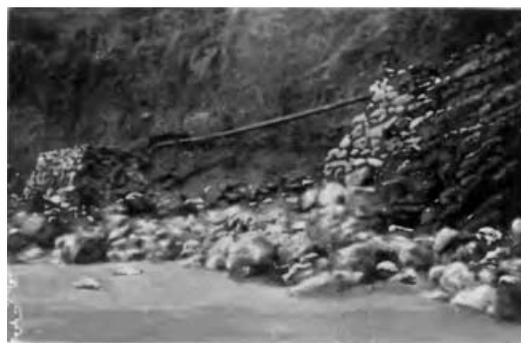
Eboulement à Safi (Maroc) d'une falaise au pied de laquelle la conduite d'eau en tuyau d'acier de 250 m/m est demeurée intacte, en service.
