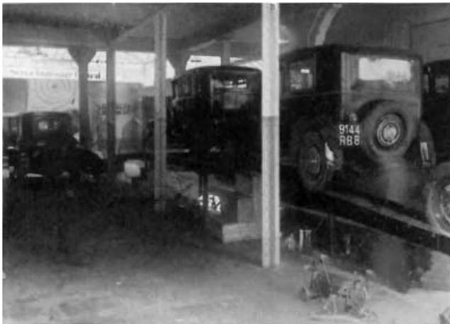
*Le graissage de la voiture effectué sur le « Pont » à la station modèle de la rue Brunel.*
