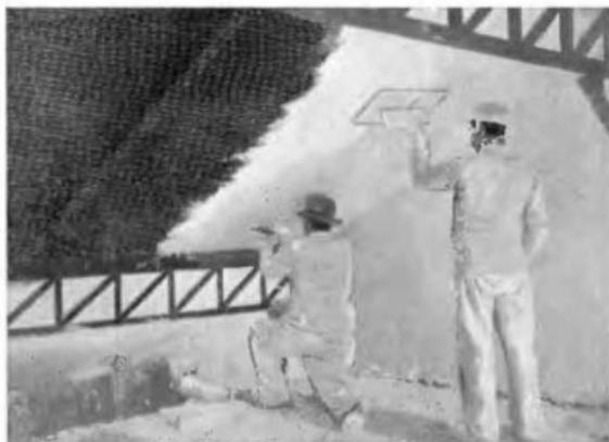
Exécution sous toiture d'un plafond en plâtre sur M. D. dans les ateliers de MM. SCHNEIDER ET Cie, au Creusot.
