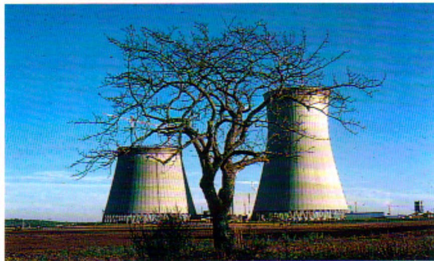
Les réfrigérants de la centrale nucléaire de Dampierre-en-Burly sur la Loire (1976).
