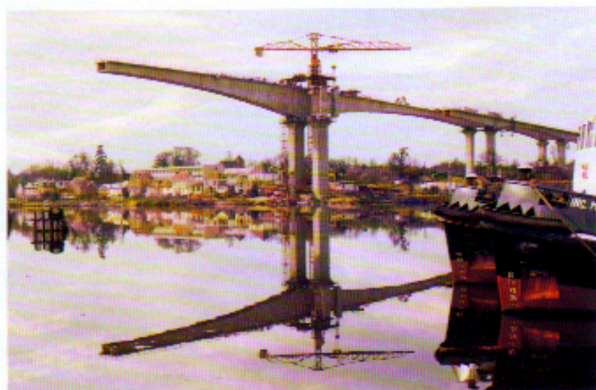
Viaduc de Caix à Caen. Travée centrale de 156 m en cours de construction (1975).
