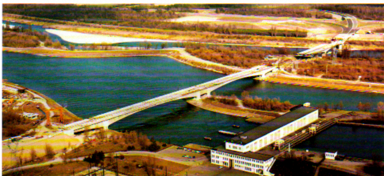
Ponts d'Otfmarsheim sur le canal latéral au Rhin (portées 172 et 144 m) et sur le Rhin (portée 110 m) construits de 1977 à 1980.
