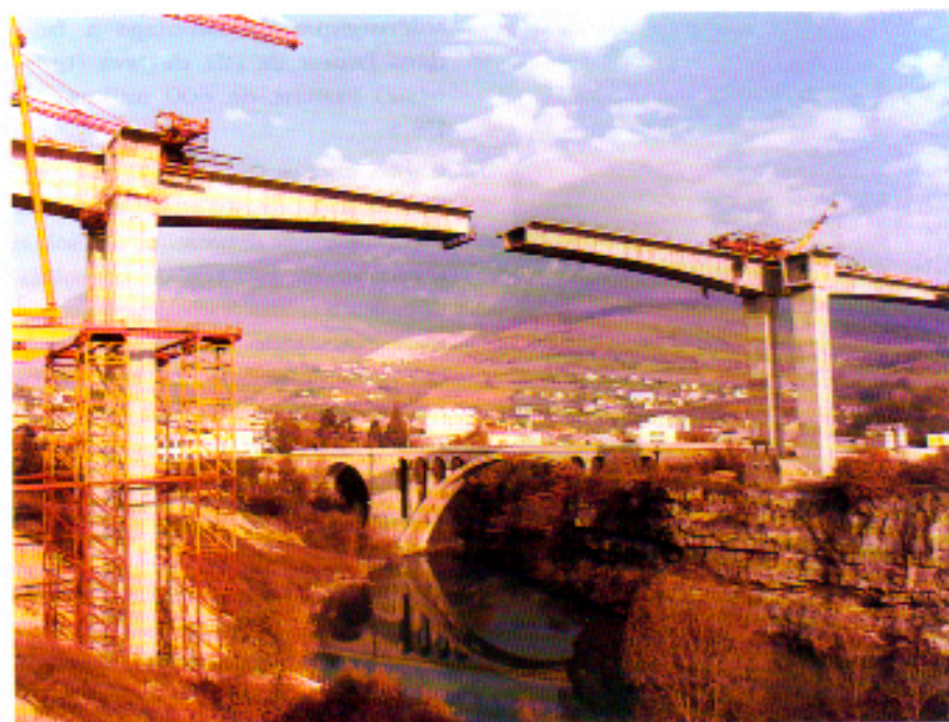
Le viaduc de Bellegarde (construit en 1982) et, en arrière-plan, le pont de Bellegarde (achevé en 1948).
