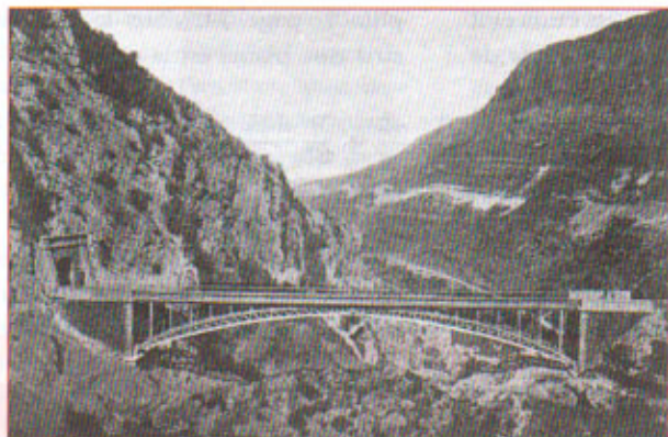
▲ Pont en arc à trois rotules, sur la Saf-Saf (Algérie). Corde 68 m, flèche 6,70 m, voie en courbe de 300 m de rayon.
