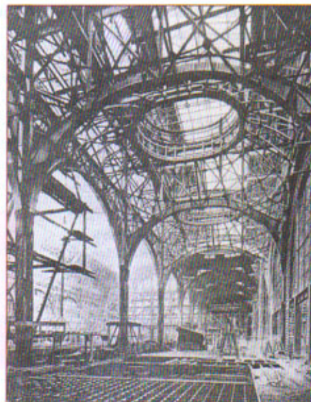
► Gare du quai d'Orsay, à Paris. Ossature métallique des coupoles du vestibule.
