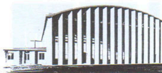
Hangar d'aviation à Pancevo, Serbie, près de Belgrade, façade constituée de « V Laffaille » préfabriqués, 1937
