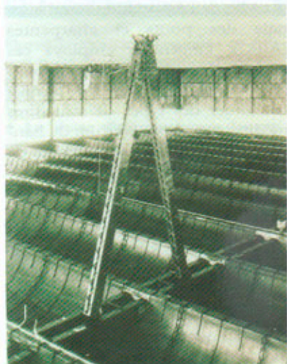
Hangar à Cazaux, 1935-1936, couverture en tubes cylindriques de 37 m de portée
