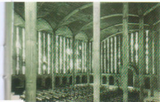
Eglise de Bizerte (Tunisie) ; Jean Le Couteur, architecte. Vue intérieure de la nef constituée de paraboloides hyperboliques en coques de béton armé. Façade composée de « V Laffaille », 1950-1953
