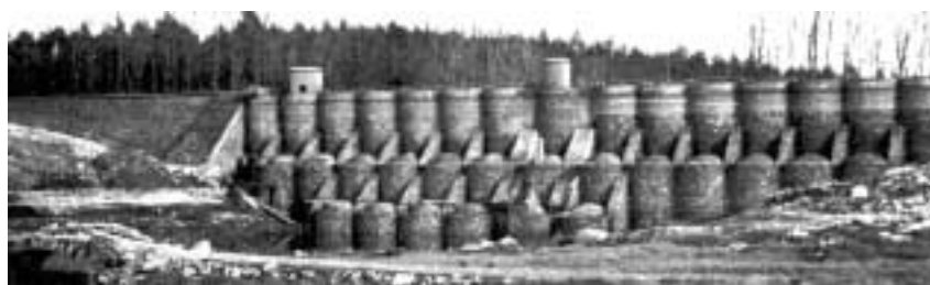
BARRAGE DE MONTAGNÈS PRÈS DE MAZAMET, EN BÉTON ARMÉ DE TYPE NID D'ABEILLES ( BREVET H CHABAL ) 1934
