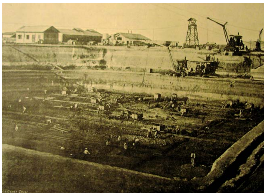
LES TRAVAUX DU PORT DE ROSARIO
