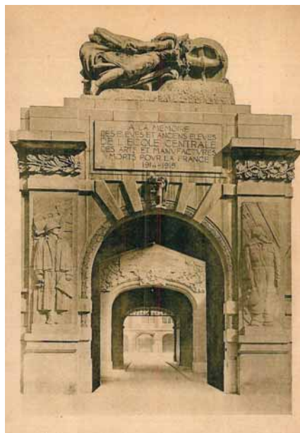
Monument aux morts (anciens locaux, à Paris, rue Conté) érigé en 1923
