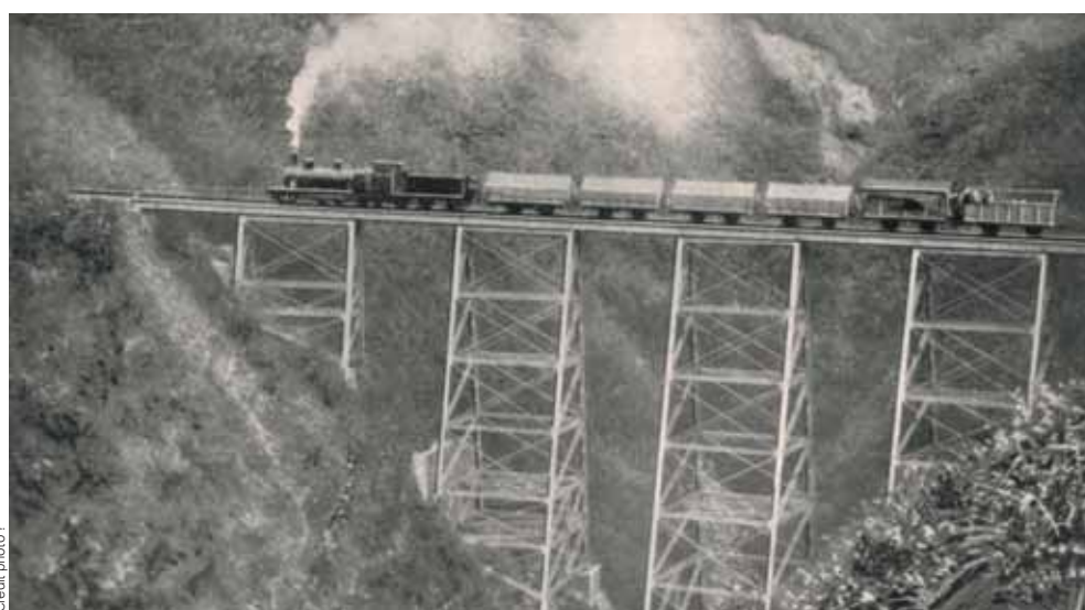
Ouvrage terminé, passage d'un train
