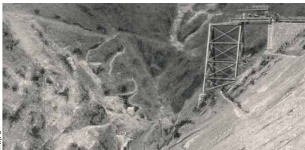
Pont en cours de montage
