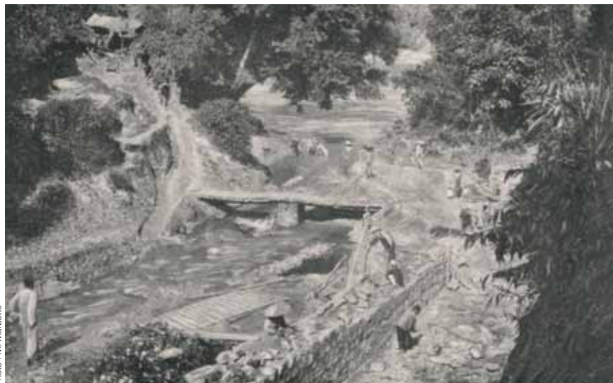
Chemin de service, passerelle et un aqueduc voûté de 2 m. au Km. 14,5 (en construction)
