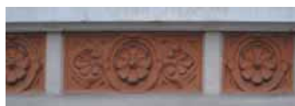
Fig. 5 - Détail d'un panneau de terre cuite au rez-de-chaussée, 20, avenue du Président Wilson (16 e ).
