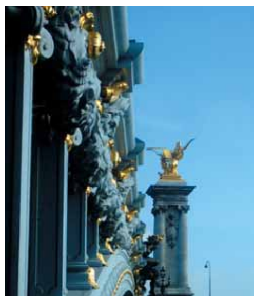
Pont Alexandre III (1896-1900) ; la fonderie Durenne a eu en charge les fontes décoratives du pont : balustrades et guirlandes (les autres décors sont en bronze et en cuivre repoussé). On voit à l'arrière de la photo l'un des Pegases en bronze doré ; des quatre Pegases (ou Renommées), deux ont été réalisés par la fonderie Durenne (situés côté Champs-Élysées), les deux autres étant signés du Val d'Osne (côté Invalides).
