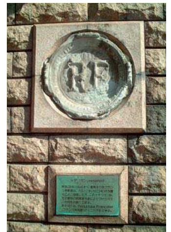
Médailleon RF vestige de l'ambassade construite par Sarda, conservée dans le parc Furanou Yama.
