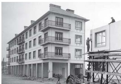
Immeubles en construction au sein de l'îlot N17 du Havre. Au premier plan des ouvriers entraînent de coffrer un poteau d'angle de l'ossature.
