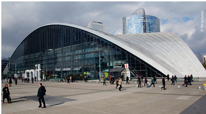
Le Cnit construit sur l'esplanade de La Défense. Un autre ouvrage auquel Gilbert Lacombe a participé entre 1956 et 1958. La portée de voûte en béton armé mesure 218 mètres.
