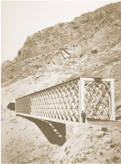
Ponts ferroviaires du défilé de los Gaitanes.
