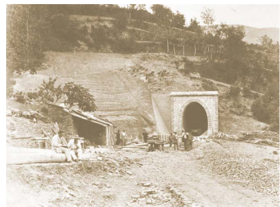
Construction d'un tunnel sur la ligne Pistoia-Bologne.
